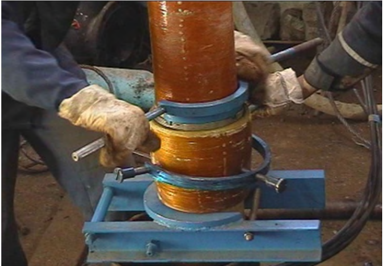
Стыковка труб в артезианской скважине
